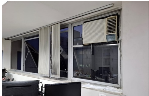
Cj. 82 – Fiscalização – 3 janelas com divisões modulares e recortes para equipamentos de ar condicionado
